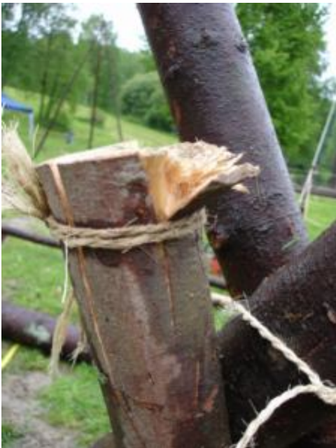
Plugg som har blitt slått ned og delvis Splittet, men halvstikken stanser splittingen (Bildet er ikke fra karusellen)
