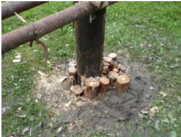
Plugg rundt telefonstolpen etter at de har blitt kappet
